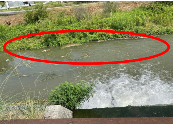
図4 渦により滞留した浮遊ゴミ
